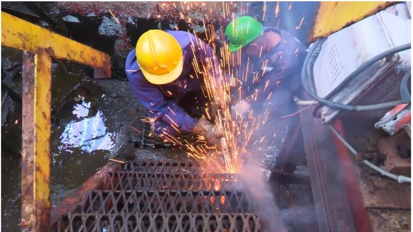
Trabajos intensivos en la bomba de circulación de la unidad número 3 de la Central Termoeléctrica Antonio Maceo son acciones que se acometen como parte del mantenimiento ampliado a ese bloque térmico.
